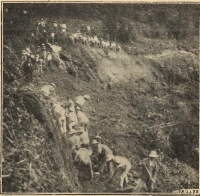
Il lavoro su un tratto della strada Pan-Mendez .
