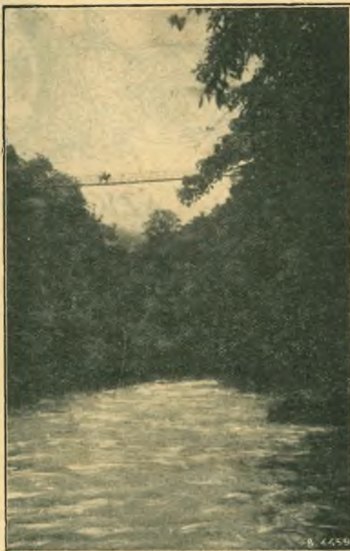
Il ponte sul Namangosa visto dal fiume.
